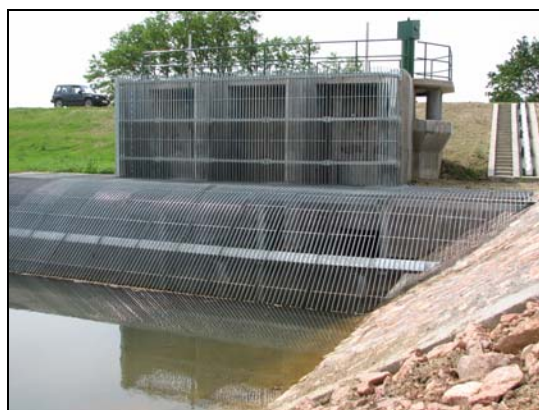
Slika 18: Zapornični objekt z grabljami na Ivanjševskem potoku. (Foto: J. Novak)
